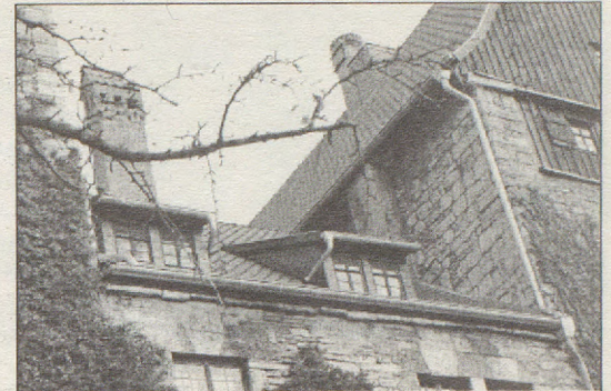
...und nach Fertigstellung mit neuem Schornsteinkopf, Schieferflächen, neuen Dachrinnen- und -kästen im Oktober
