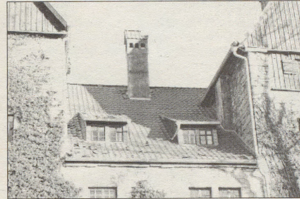
...und nach Fertigstellung mit neuem Schornsteinkopf, Schieferflächen, neuen Dachrinnen- und -kästen im Oktober
