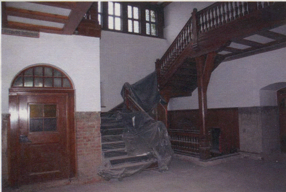
Eingangshalle während der Bauphase mit neuer Stahlbetonplatte
