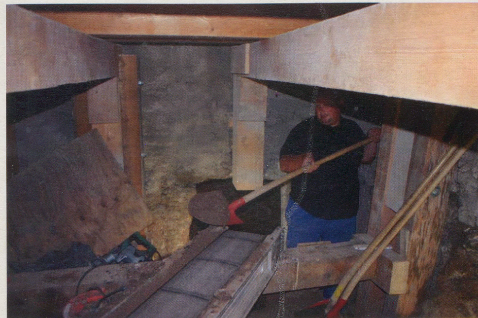
Bergbaumäßige Unterfangung im Keller im Bereich des geplanten Treppenhauses
