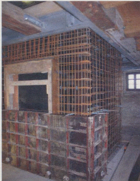
Aufzugsschacht im 3. Obergeschoss, Stahlbewehrung und Schalung
