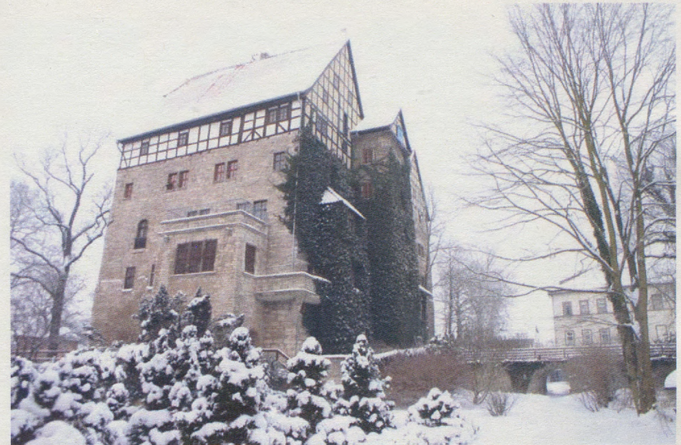
Burg im Winterkleid, die Arbeiten im Nordturm werden weitergeführt
