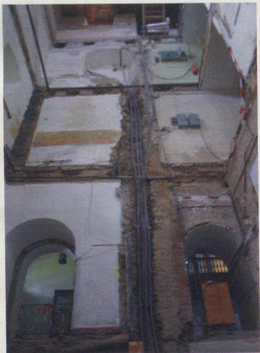
Abgebrochene Decken und Wände für das neue Treppenhaus
