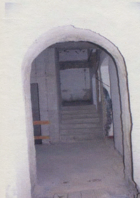
Blick vom Windfang zur neuen Treppe mit Aufzugsschacht
