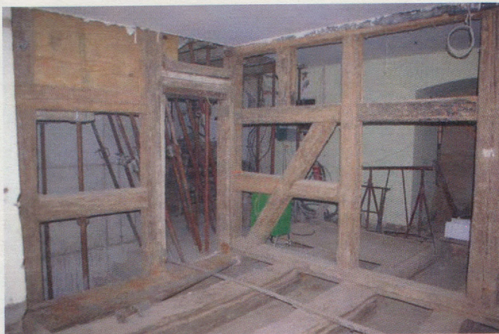
Entkernte Decke und Fachwerk im 2. Obergeschoss (teilweise marode Deckenbalken)
