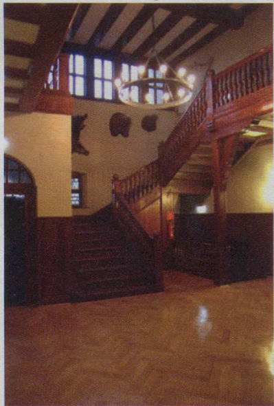
Blick zur Freitreppe in der Kaminhalle mit aufgearbeitetem historischem Parkett
