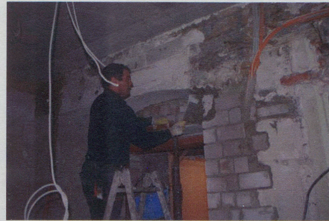
Herstellen der Türöffnung auf dem Treppenpodest im 2. Obergeschoss Nordturm zum Mittelbau als späteren Zugang zu degeplanten Toiletten
