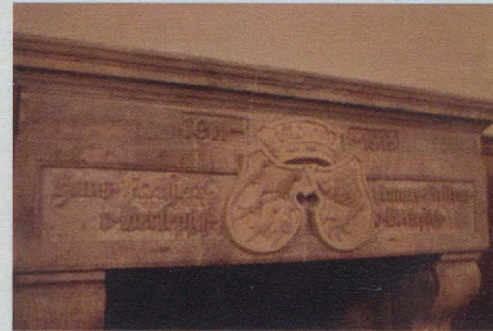
Rekonstruierter Kaminsturz. Die Wappen mit Krone und die Schrift sind bewusst nicht retuschiert, sondern als rekonstruierte Teile heller gehalten
