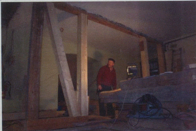
Instandsetzung der Fachwerkwand im 2. Obergeschoss Nordturm für den Sanitärraum Zivi und für den Datenraum
