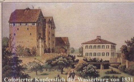
Colorierter Kupferstich der Wasserburg von 1831
