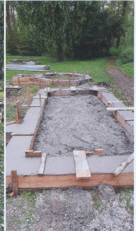
Schalung und eingefülltes Fundament (oben) / Volierenteile im Baukastensystem (unten)
