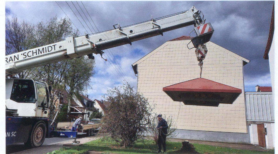
Nur mit dem Kran war die schwere Konstruktion zu bewegen
